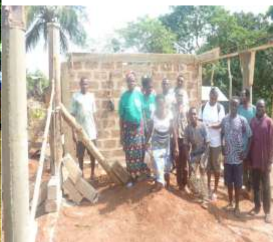
Construction d'un atelier de travail à Lisségazoun
